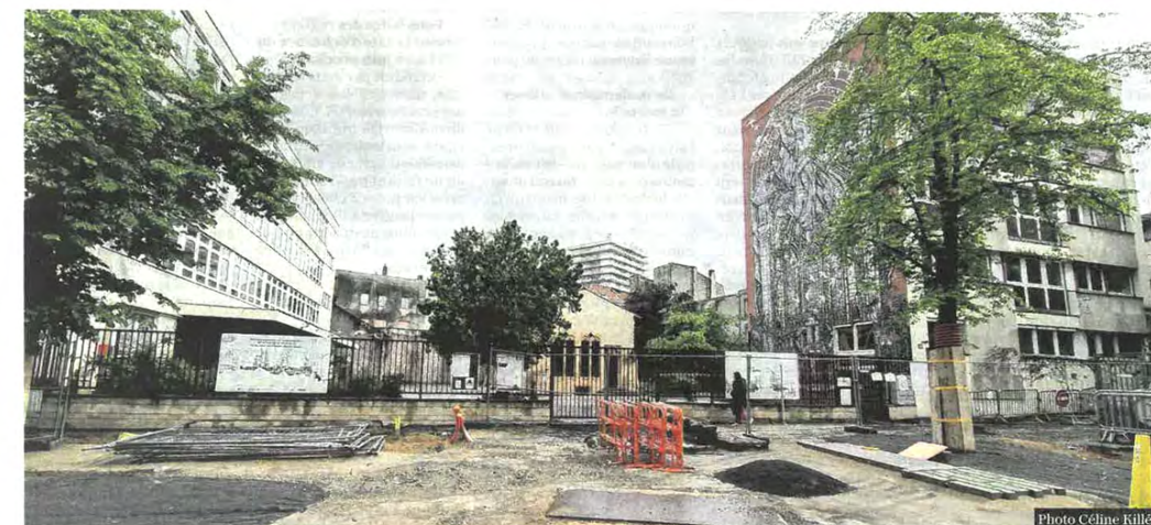
Metz • La rue de la Chèvre est en travaux depuis mars et un problème d'approvisionnement des pavés retarde le chantier. Un revêtement provisoire va être posé pour l'été
